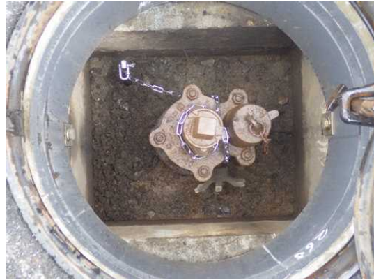
弁室への測定器挿入状況
